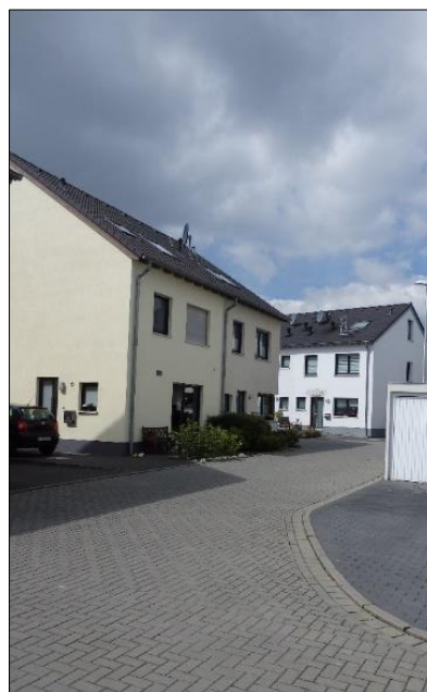
Ansicht der Erschließung im Hofbereich
