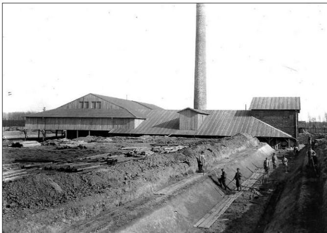
Tonabbau in den 1930er Jahren in der ehemaligen Ziegelei Goossens, später Firma Grünzig an der Nordstraße in Brand
