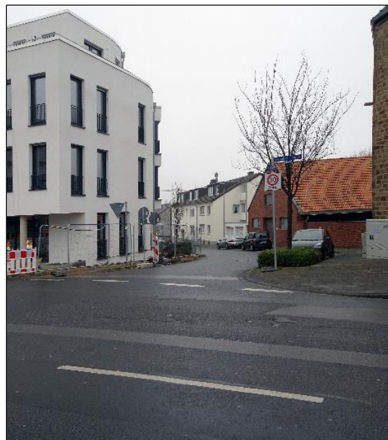
Einfahrt in die Straße von der Freunder Landstraße, links der Neubau an- stelle der ehemaligen Saalbetriebe Ellerhof
