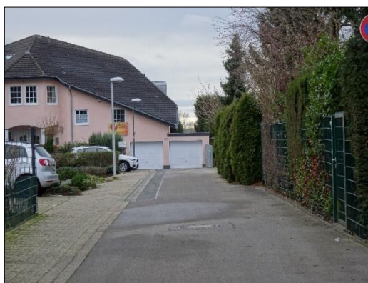
Der südwestliche Straßenteil von der Straße Im Kollenbruch gesehen
