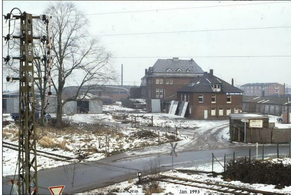
Zufahrt zum Technischen Hilfswerk (THW) in der Eckenerstraße 1993
