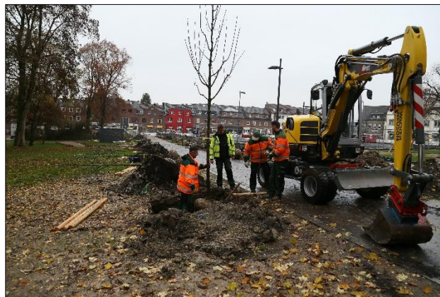
Pflanzenarbeiten 2016 nach dem Neubau des Weges
