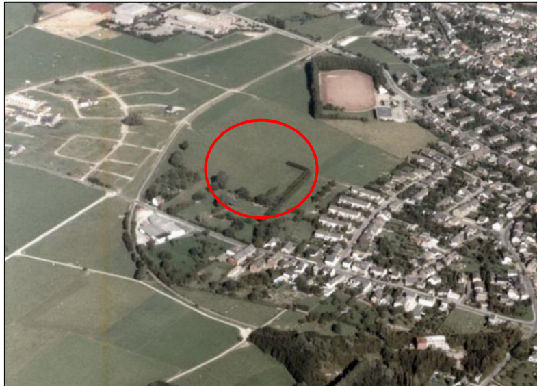
Luftbild vom Branderfeld und Teilen von Niederforstbach; markiert ist die Lage der künftigen Franz-Wallraff-Straße und des Liefenwegs.
