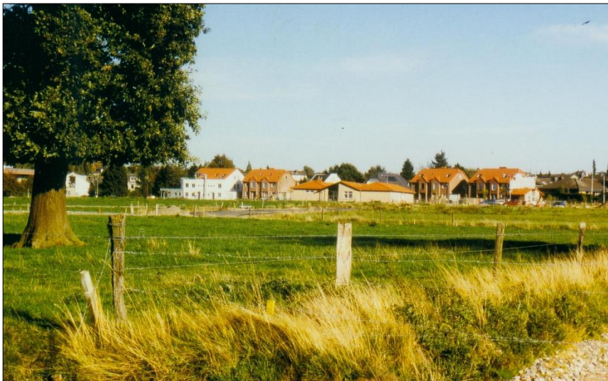
Die künftige Franz-Wallraff-Straße (Bildmitte) noch als Baustraße, am Horizont verläuft die Wilhelm-Ziemons-Straße mit ersten Häusern.
