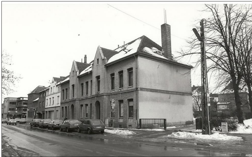
Hochstraße zwischen Kirche und Trierer Straße; das mittige Gebäude ist um 1862 die ehemalige Mädchenschule.
