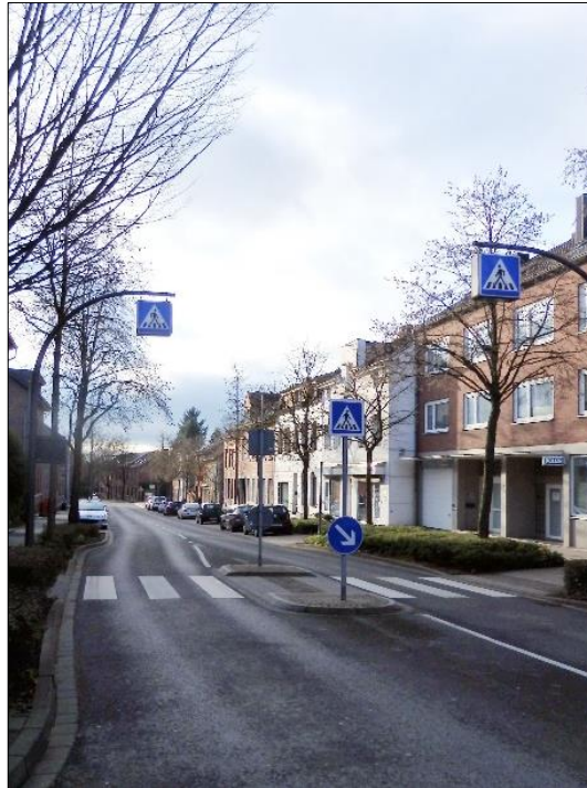
Ansicht von der Einmündung Rollefstraße in Richtung Niederforstbach
