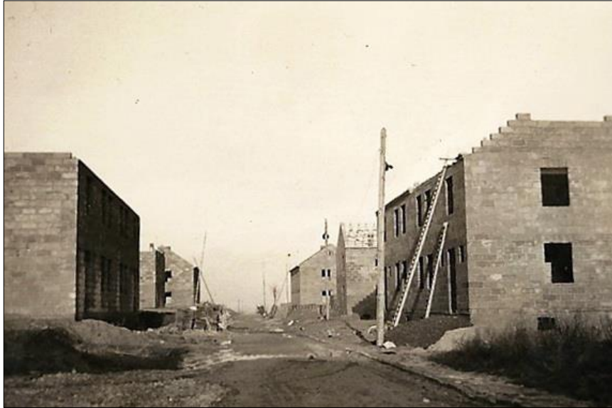
Fortgeschrittene Bautätigkeit in der Siedlung
