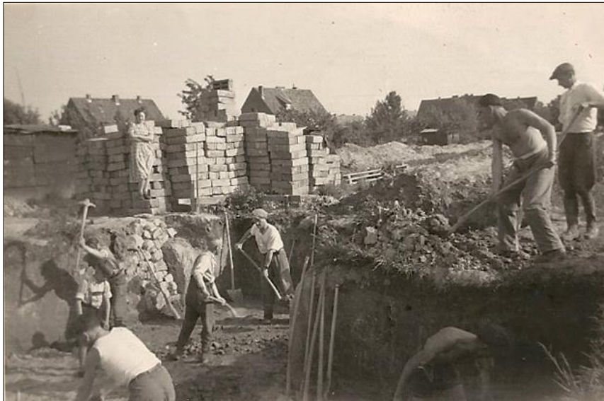
Auf einer Baustelle in der künftigen Siedlung In den Heimstätten
