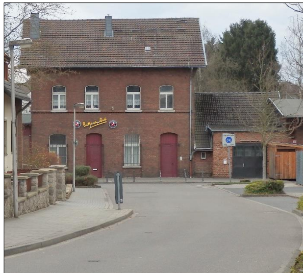
Blick von der Nordstraße auf das ehemalige Bahnhofsgebäude (früher ein Teil der Bahnhof- straße)
