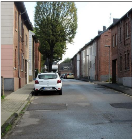
Zufahrt in die Straße vom westlichen Teil der Schroufstraße
