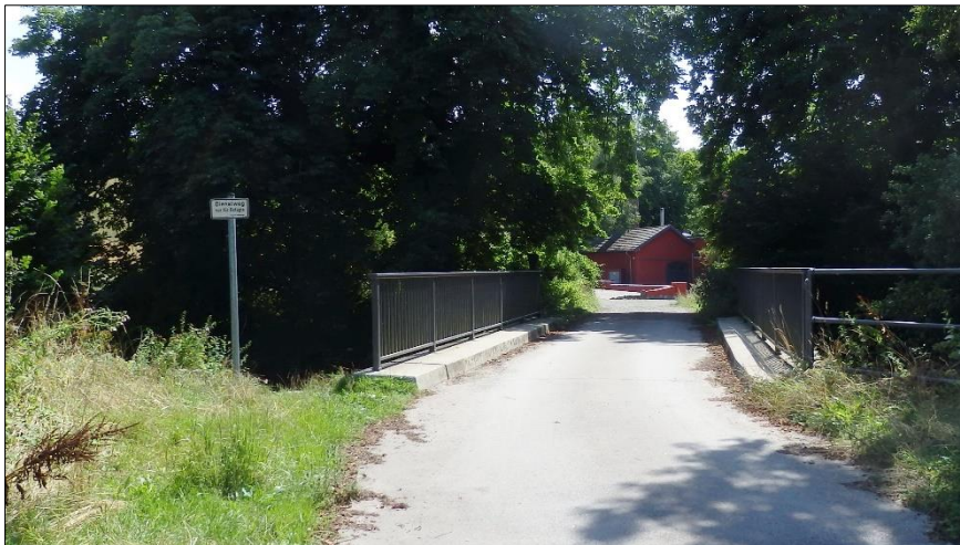
Ansicht des Weges an der Indebrücke
