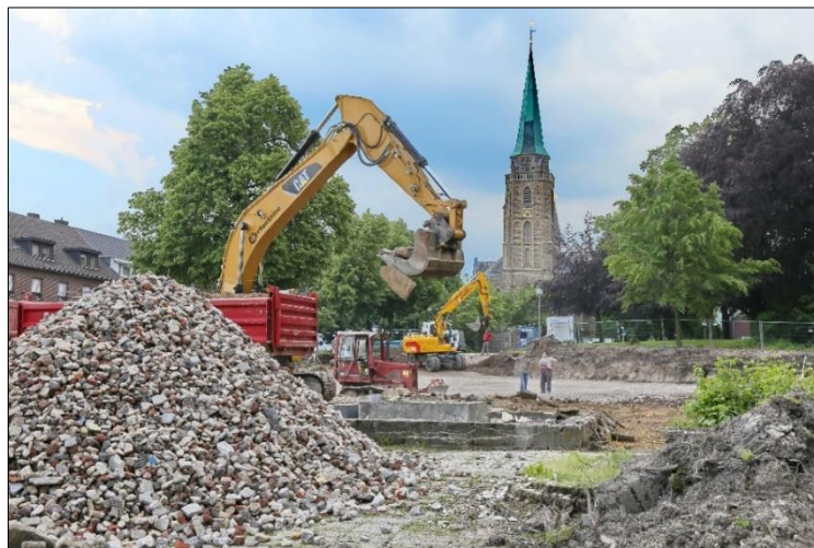
Fotos vom Umbau des Marktplatzes im Sommer 2016
