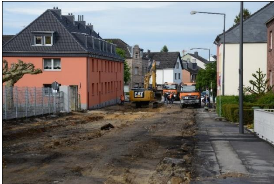
Blick in die Marktstraße nach Beginn der Umbau- arbeiten
