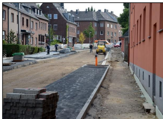
Straßenbauarbeiten in der Marktstraße
