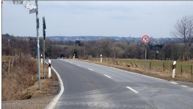
Die Niederforstbacher Straße bei Bierstrauch, Blick in Richtung Brand (oben)
