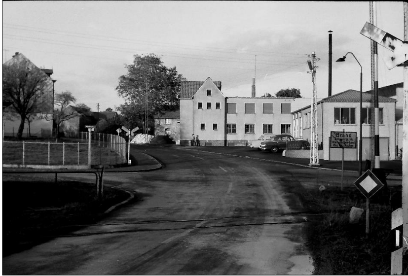
Kreuzung Niederforstbacher Straße mit Kapellenstraße und Münsterstraße und Bahnübergang
