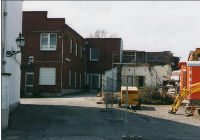
Abbruch der ehemaligen Weberei Ortmanns an der Rollef- straße (Anfang der 2000er Jahre)
