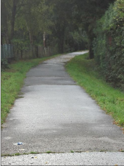
Einsicht in den Schroufer Damm von der Schroufstraße
