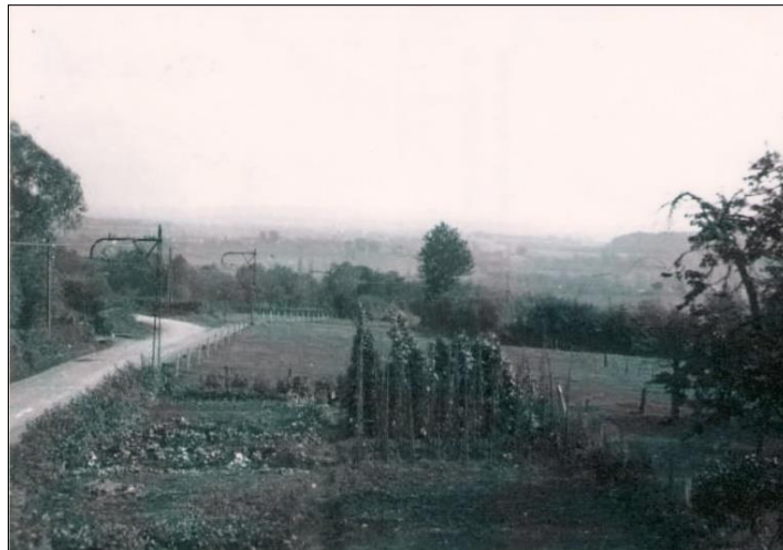
Die westliche Schroufstraße: Die Straßenbahnlinie verläuft auf der rechten Straßenseite, ab der Linkskurve biegt sie rechts ab und führt über einen Damm (heute Schroufer Damm) in das Indetal bis Kornelimünster Markt.
