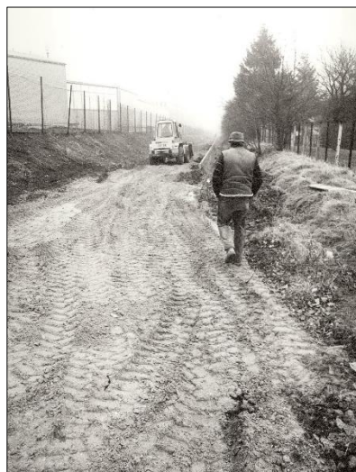
Ausbau des Weges im Bereich der damaligen Tuchfabrik Becker zwischen Münsterstraße und Beckerstraße
