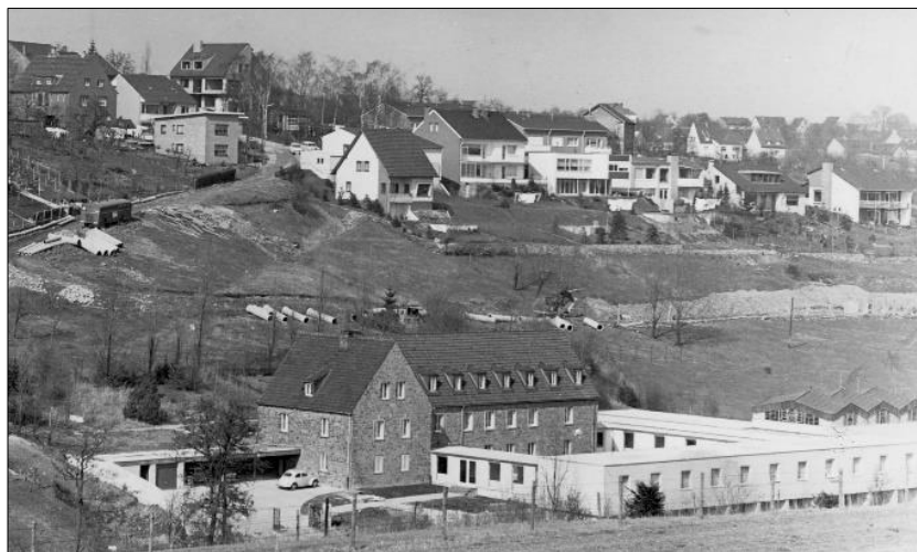
Ausbau und Erschließung der Wendelinstraße im unteren Bereich
