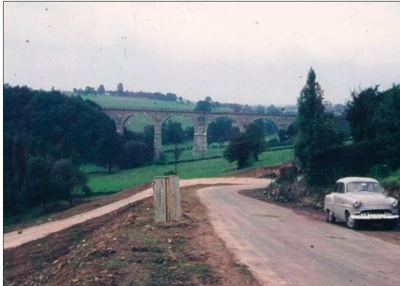
Ausbau der Wendelinstraße; (hier als Baustraße) zur Erschließung der geplanten Bebauung
