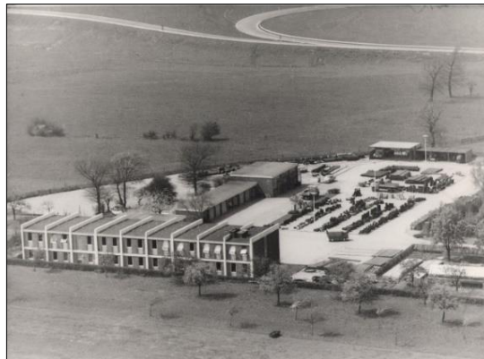
Betriebsgelände (Hof) des Wasserwerks in Brand in den 1960er Jahren; im Hintergrund die Auf-/Ab- fahrt der Autobahn A 44
