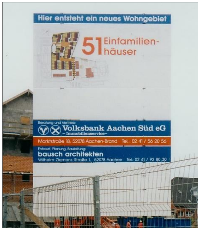
Bauschild: Neubau eines Wohngebietes
