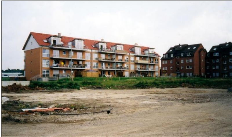
Freigeräumte Fläche des Wasserwerks (Werkstattgebäude) hinter der Heussstraße
