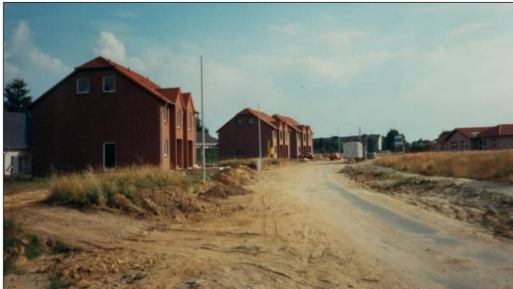
Die Wilhelm-Ziemons-Straße im Jahr 1993 noch als Baustraße; Blick in Richtung Niederforstbach; mit der Bebauung wurde begonnen, rechts der Kindergarten (Ecke Franz-Wallraff-Straße).
