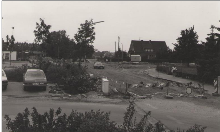
Ausbau der Kreuzung Wolferskaul / Rombachstraße vor dem Sportplatz und der Schwimmhalle (beide hier nicht sichtbar), geradeaus beginnt hinter der Kreuzung die Rombachstraße, vorn links befindet sich die Einmündung der heutigen Wilhelm-Ziemons-Straße.
